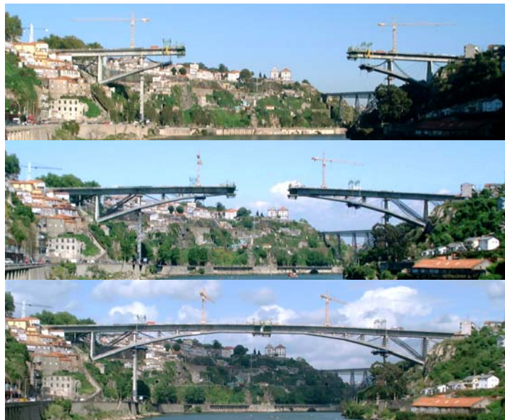
Figura 2 – Alçado geral durante a construção
