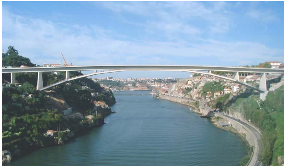
Figura 1 – Alçado da Ponte
