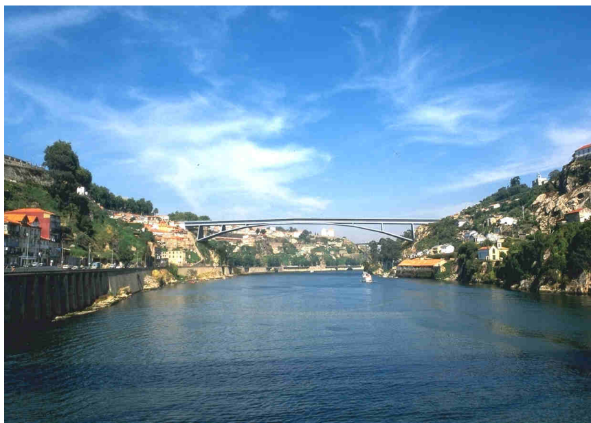
Alçado da Ponte vista do tabuleiro inferior da ponte Luiz I
