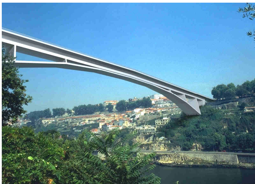
Perspectiva da Ponte vista da margem esquerda
